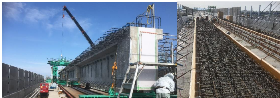
北陸新幹線のプレキャストのPC桁の架設
